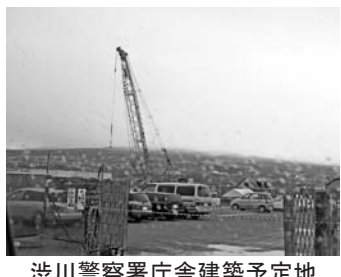
渋川警察署庁舎建築予定地
